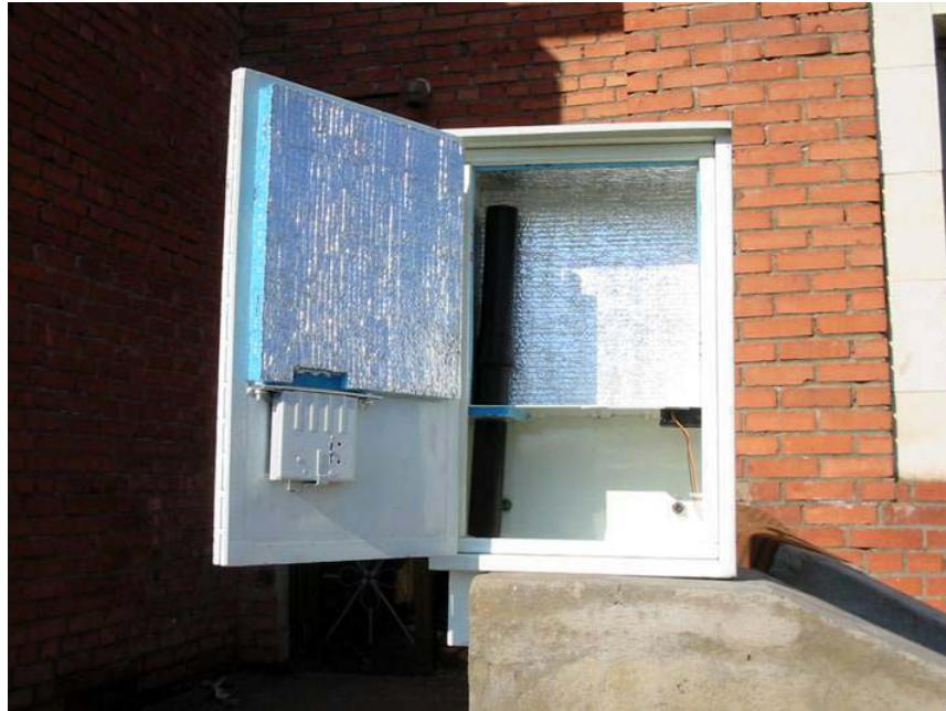
Рис. 2.12: Термобокс: вид внутри
