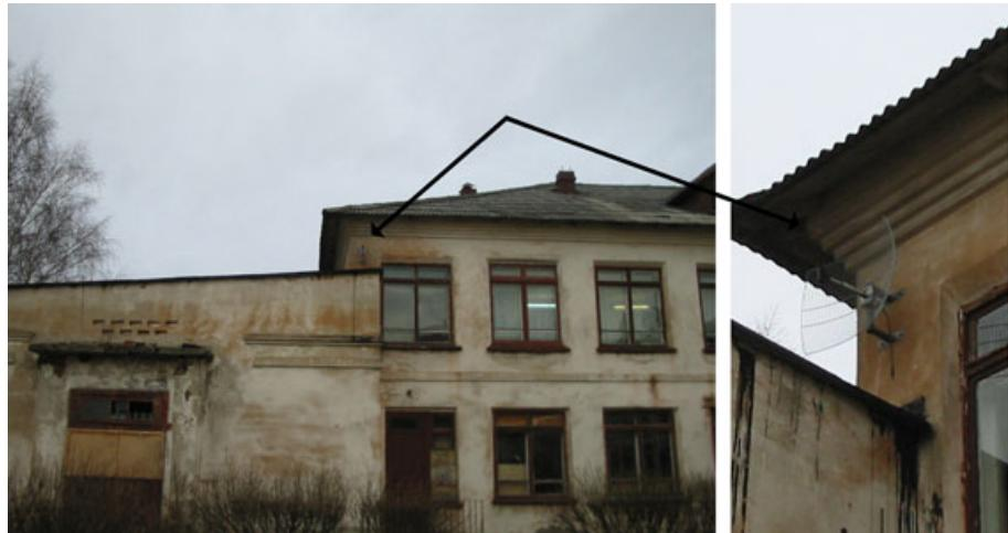
Рис. 1.15: Школа в поселке Купанское. Параболическая антенна беспроводного подключения ЛВС школы к компьютерной сети
