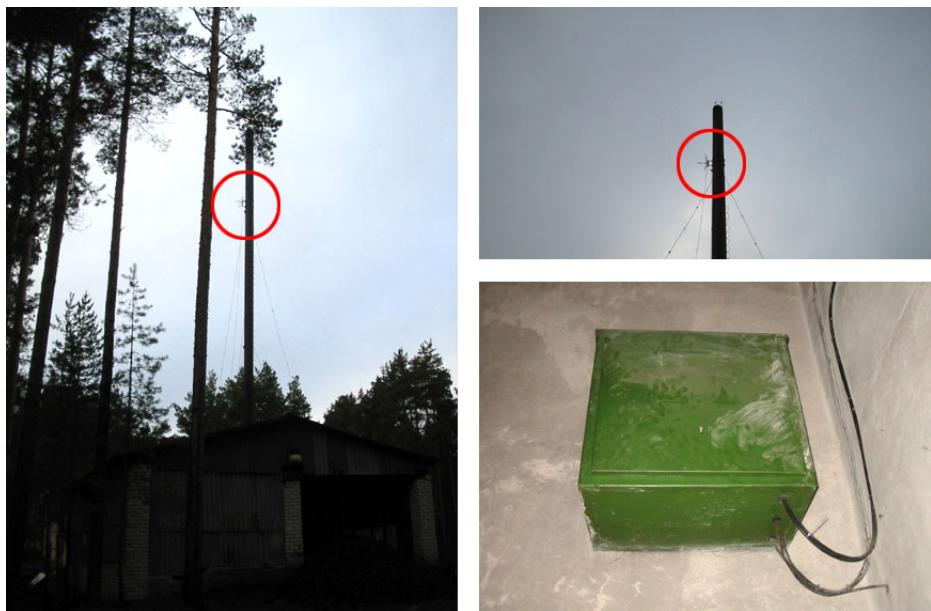
Рис. 1.12: Урочище Кухмарь: магистральный узел расположен в котельной, для размещения антенны (и обеспечения прямой видимости) используется существующее высотное сооружение (труба котельной)
