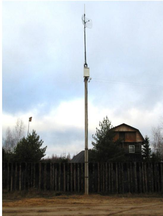
Рис. 1.14: Поселок Купанское: магистральный узел (он же узел доступа) размещен вне помещения, на специально установленном для этого осветительном бетонном столбе
