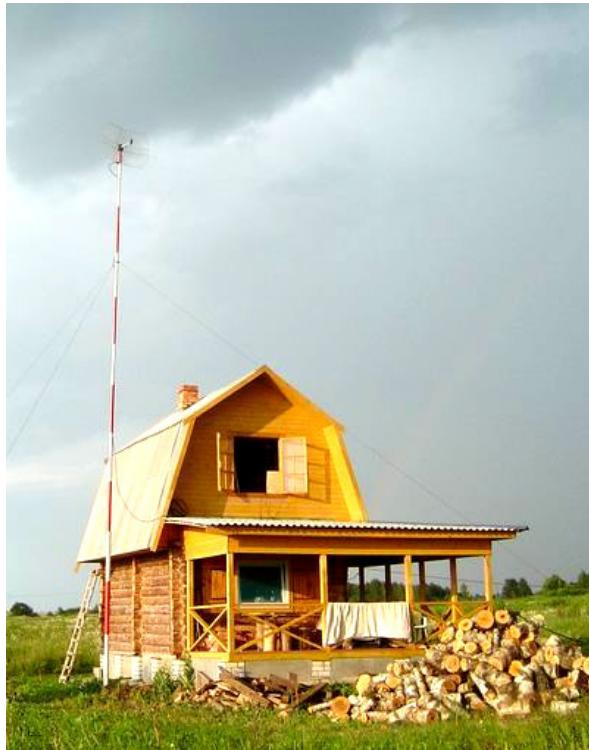
Рис. 1.11: Использование мачты собственной разработки для организации магистрального узла в селе Криушкино
